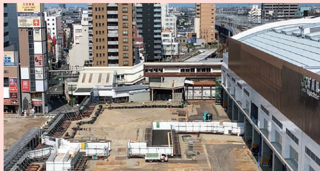
高架化工事箇所（2022年6月現在）
