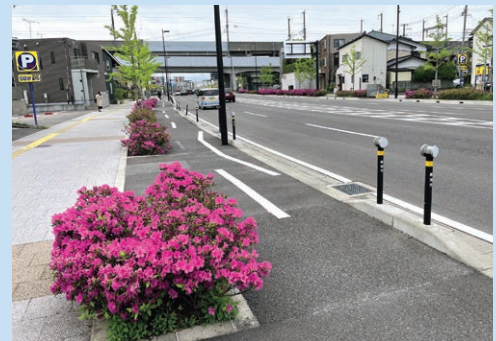
整備後の新潟鳥屋野線 (2020年3月)
