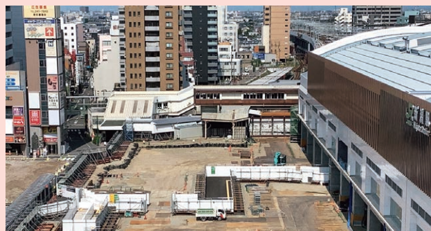
高架化工事箇所（2022年6月現在）
