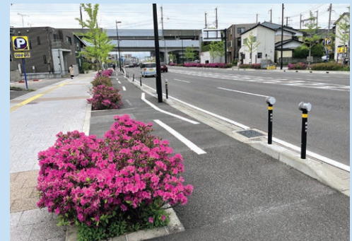
整備後の新潟鳥屋野線 (2020年3月)
