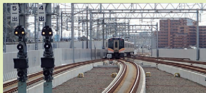
高架橋上を走行する在来線
