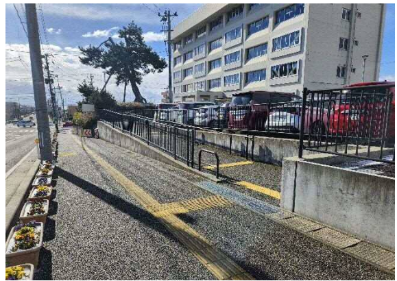
写真 6-19 さかいわ 坂井輪地区公民館
