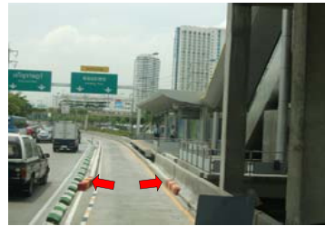
停留所での車両とホームのギャップを調整するガイドウェイバス技術
