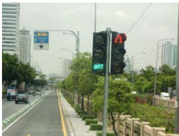
専用車線と分離制御された信号システム
