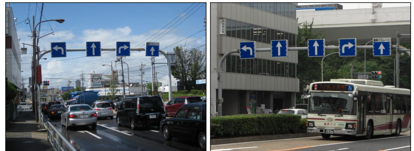
参考事例（名古屋市：門型柱を用いた進行方向の明示・信号現示による直右分離）
