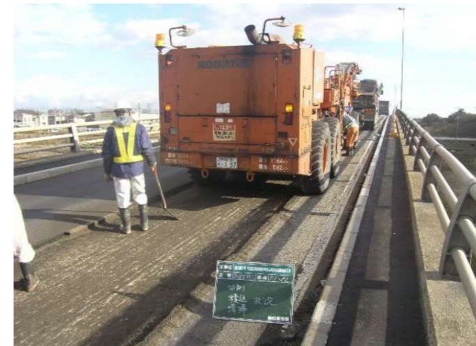
舗装打換え工
