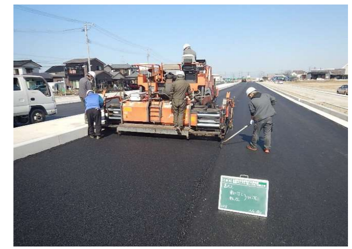
アスファルト舗装工
