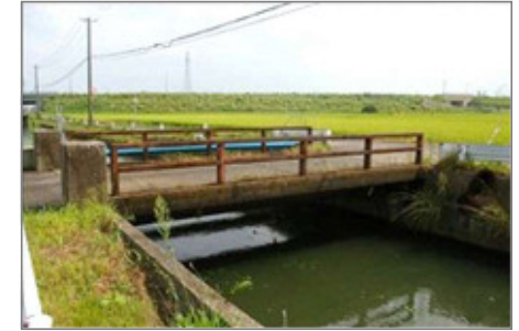
木津8号橋／廃橋・撤去
