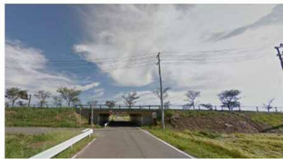
津島屋アクセス橋
