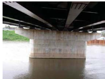
現在の耐震基準を満たしている橋脚 (阪神淡路大震災以降(H8以降)の基準)
