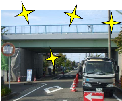
リフレッシュ工事 (老朽化対策)
