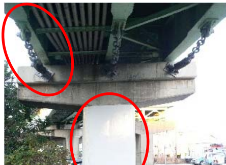
グレードアップ工事 (耐震・耐荷力補強)
