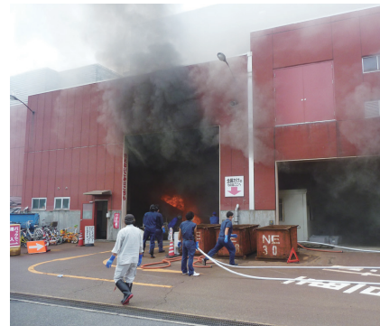
ごみ処理施設での火災の様子
