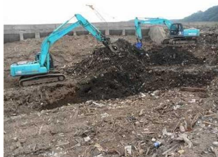
重機による災害廃棄物の山の掘削 岩手県宮古市田老一次仮置場
