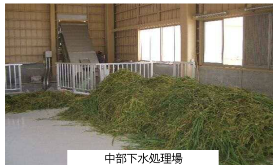
中部下水処理場
