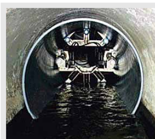
プラスチック材により既存管渠の内面を被覆します。 ＜国土交通省「下水道政策研究委員会資料」より＞
