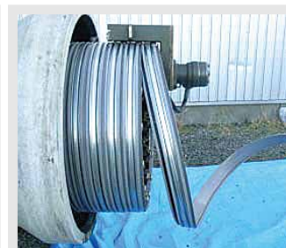
プラスチック材により既存管渠の内面を被覆します。 ＜国土交通省「下水道政策研究委員会資料」より＞
