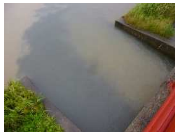
中部下水処理場の放流口
