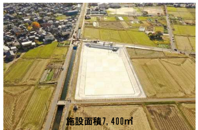
【横越雨水調整池】貯留量6,600m 3
