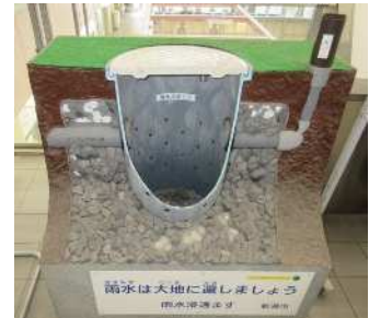
雨水浸透ます
