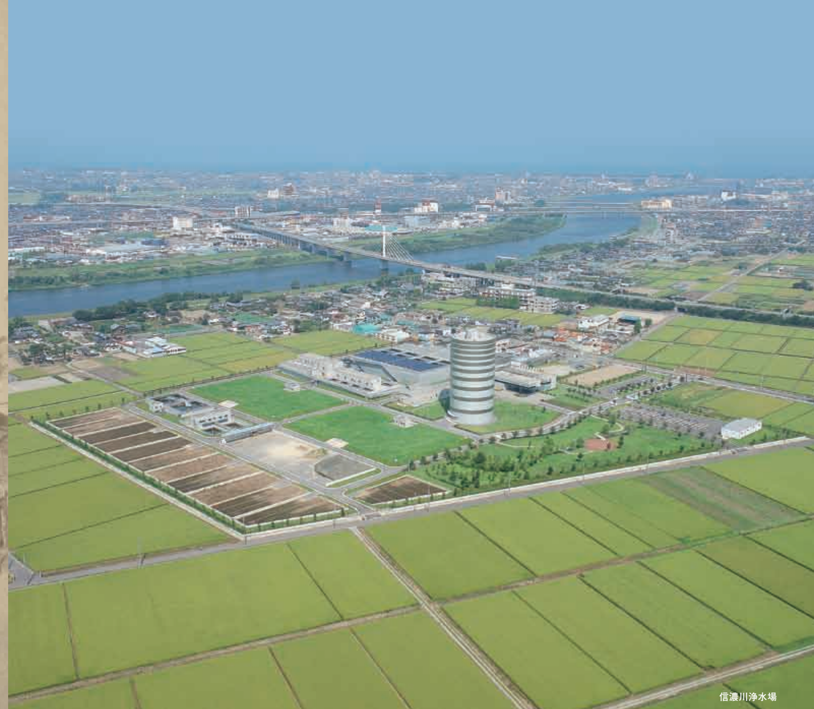
関屋浄水所のポンプ場
