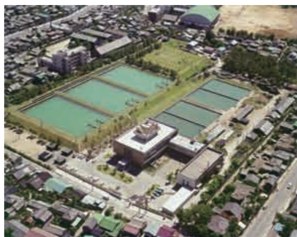
関屋浄水場構内に建設された本局庁舎
