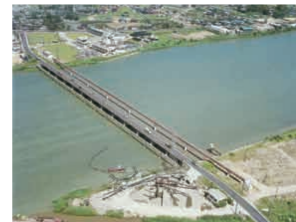
原水を青山浄水場へ導水するための信濃川水管橋
