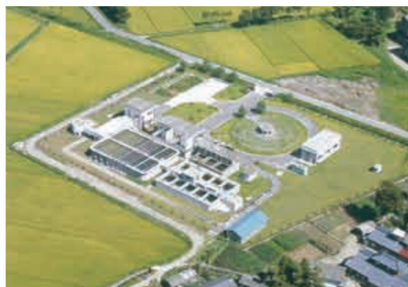
長戸呂浄水場
