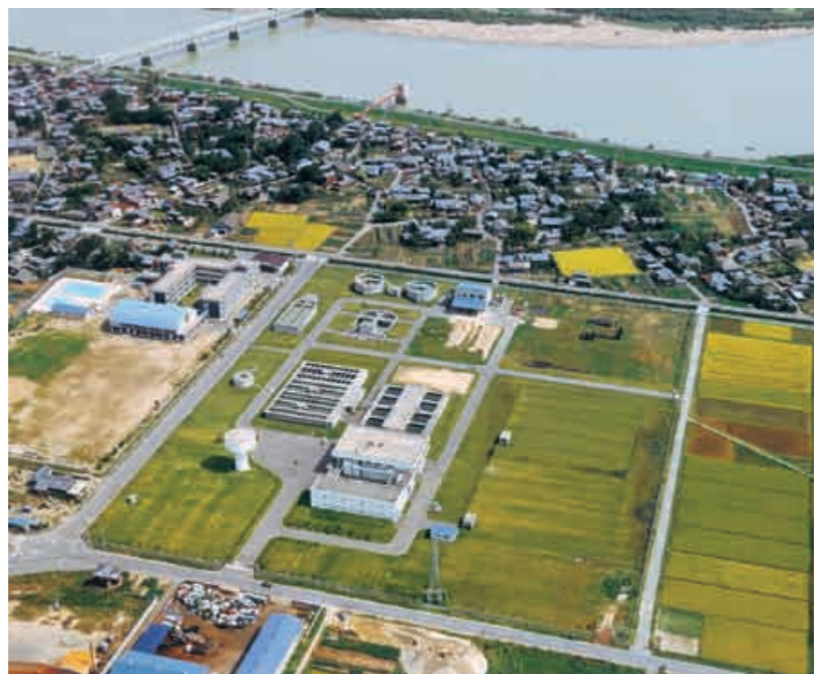
阿賀野川浄水場(第2期工事)
