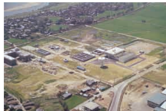
阿賀野川浄水場(第1期工事)
