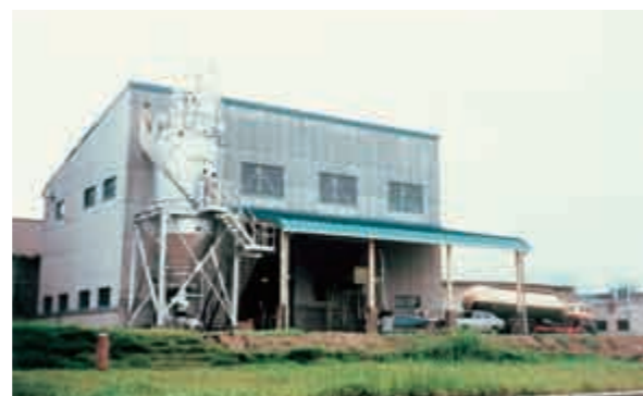
青山浄水場の脱水機棟
