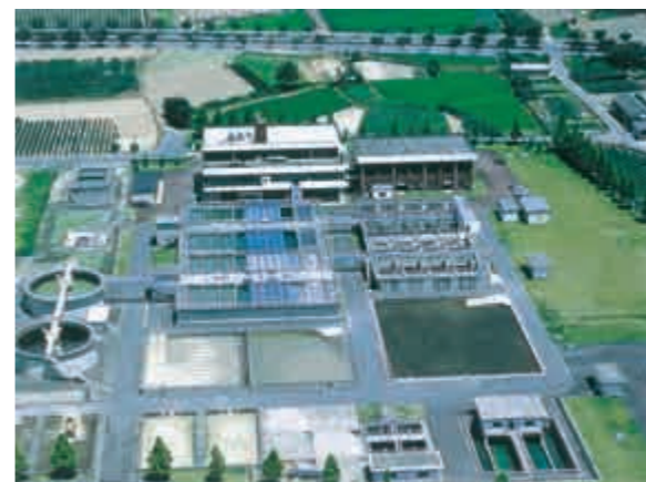
新潟東港地域水道用水供給企業団の東港浄水場
