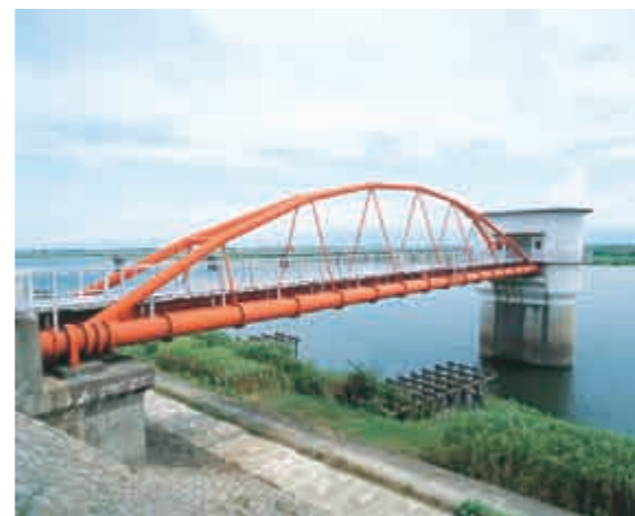
阿賀野川取水塔
