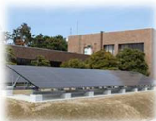
水質管理センター（19.8kw）
