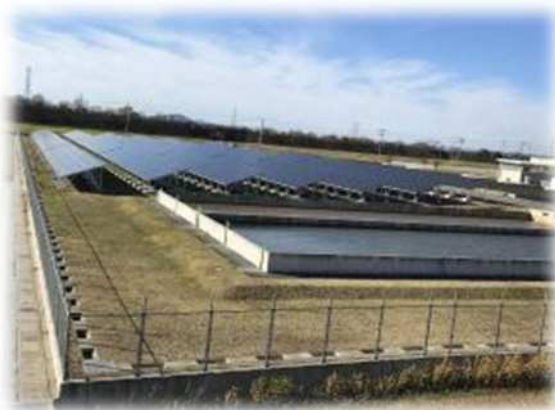
満願寺浄水場（645kw）
