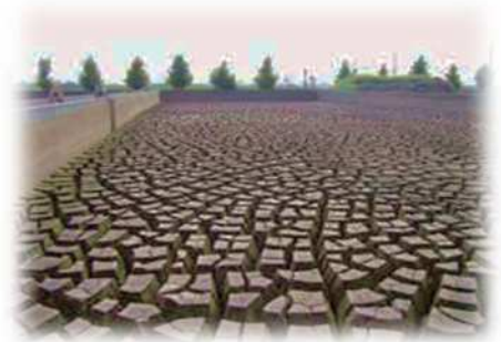
天日乾燥床(阿賀野川浄水場)
