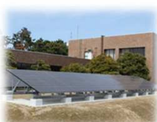
水質管理センター（19.8kw）
