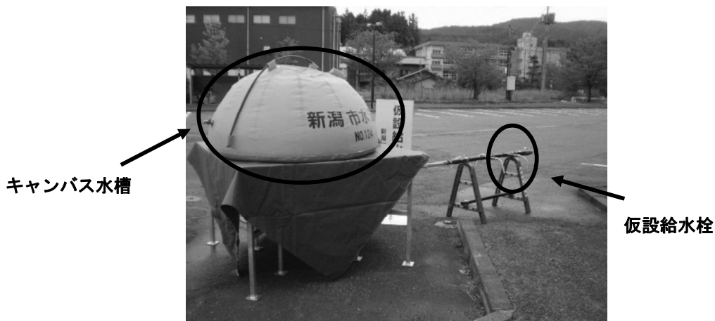
応急給水用具の「キャンバス水槽」と「仮設給水栓」の設置見本
