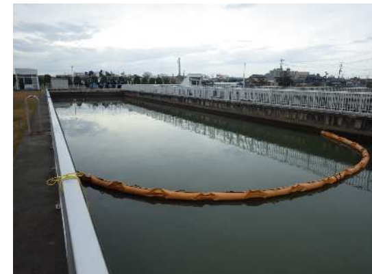
油流入を防止するオイルフェンス
