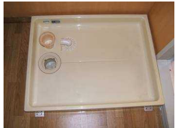
洗濯機パン排水口
