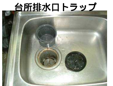
台所排水口トラップ
