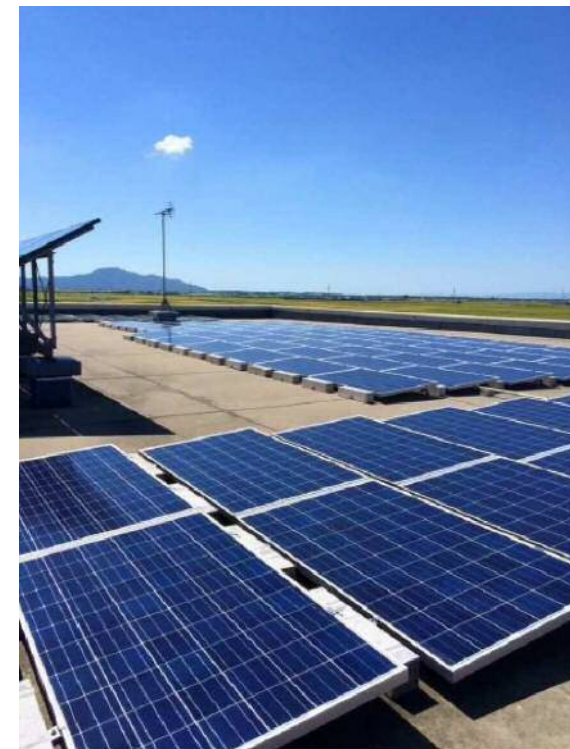
△文化財センター (屋根)
