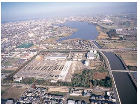
■図-20 中部下水処理場
