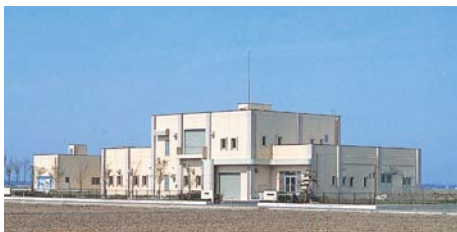
■図-21 新潟市両川浄化センター
