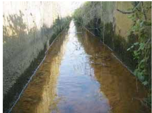
コンクリート化された用水路
