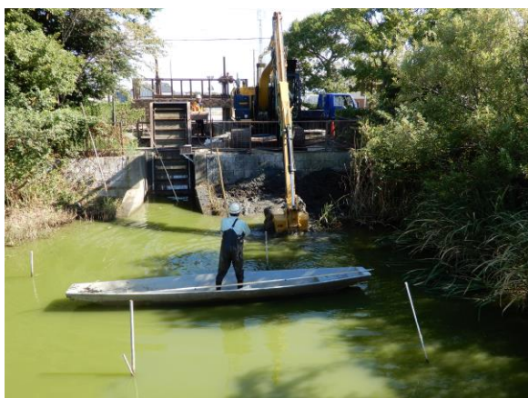
写真1 水門前の土砂撤去状況
