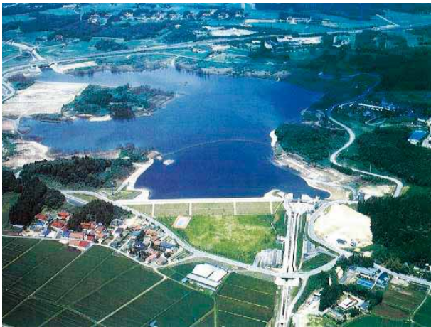
化女沼ダム（出典：宮城県「化女沼ダム」パンフレット）
