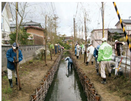
整備作業の様子
