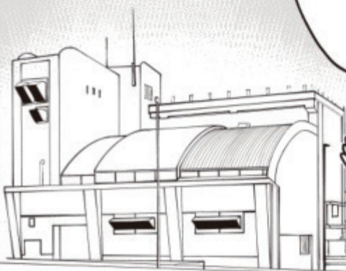
鳥屋野潟排水機場 40トン/s(洪水時)
