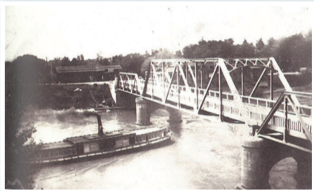
味方橋と安進丸 水かさが増すと煙突が船員2~3人で倒して橋の下を通った
