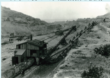
吐口付近開削工事 (信濃川大河津資料館収蔵)
