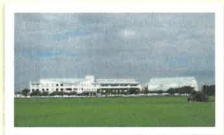
●●白井小学校 水害時は2階以上が避難所
