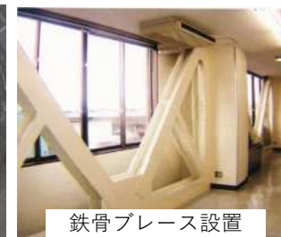
下水処理場の耐震化
