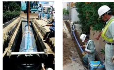
耐震管への更新工事
