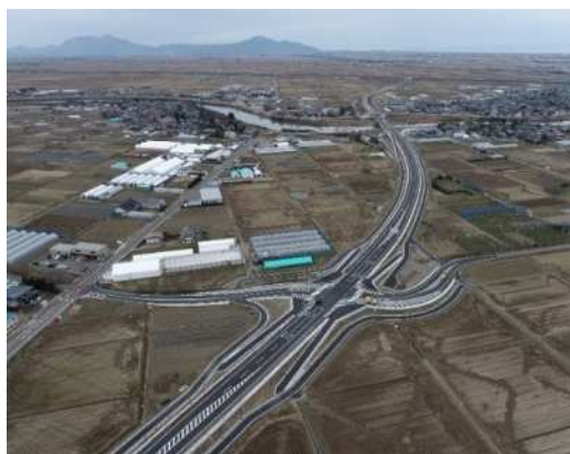
中央環状道路
