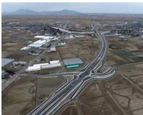
中央環状道路
