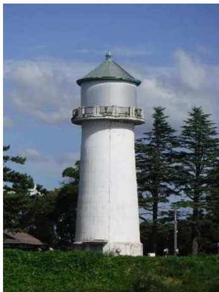
旧白根配水塔
