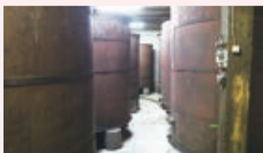
有料見学で見られる貯蔵タンク
