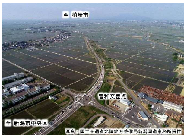
一般国道116号新潟西道路
