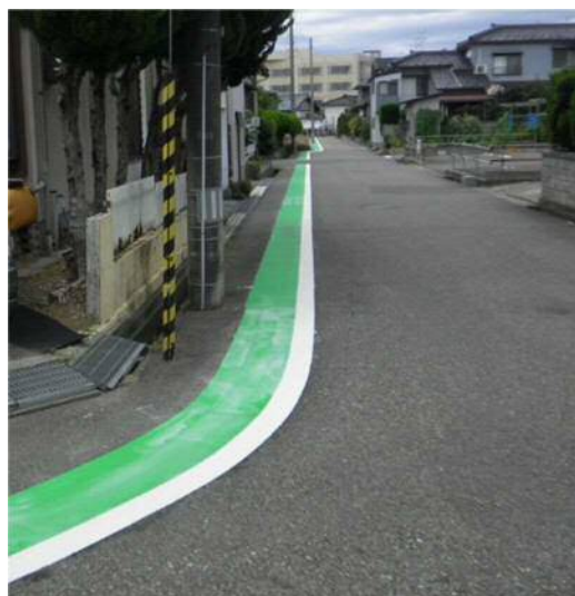
通学路の危険箇所の対策（グリーンベルト設置）
