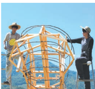
【② パイプづけ】
