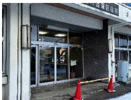
▲B棟南側玄関から見た軒下 コンクリートの一部落下
