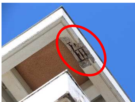
▲B棟南側玄関から見た軒下 コンクリートの一部落下
