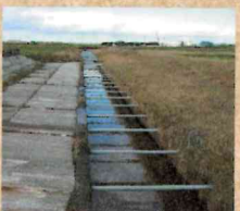
かかって流れる鎧潟第一号排水幹線。右上が鎧潟排水機場。
