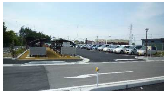
巻潟東インターチェンジ駐車場
