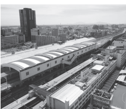
整備が進む新潟駅
