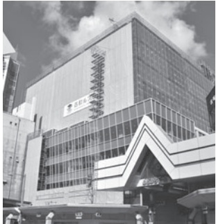
来年春の完成に向け建設が進む「古町フル」
