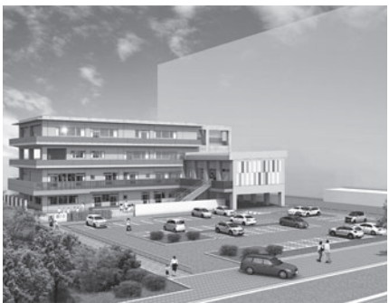
万代小学校跡地に建設中の万代保育園・東地域保健福祉センターの完成イメージ
