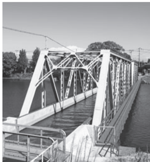
新川と西川の立体交差。下を流れる川が新川(西区)
