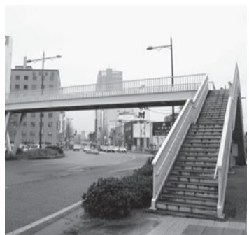
流作場五差路に設置されている歩道橋(中央区)
