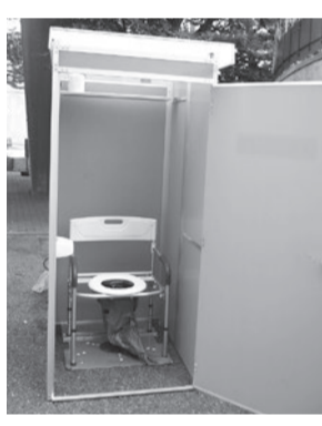
マンホールを使ったトイレ
