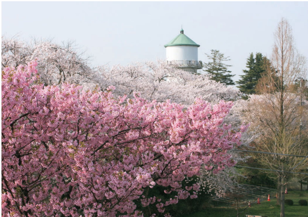
旧白根配水塔と満開の桜(南区) 旧白根配水塔は昭和8(1933)年に旧白根町の水道施設として建設され、長年地域住民の生活と産業を支えてきました。新しい浄水場の建設により現在はその役目を終えています。平成30(2018)年に国の登録有形文化財に指定され、今も地域のシンボルとして多くの住民に親しまれています。
