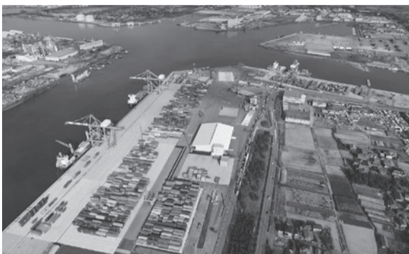
新潟東港コンテナターミナル
