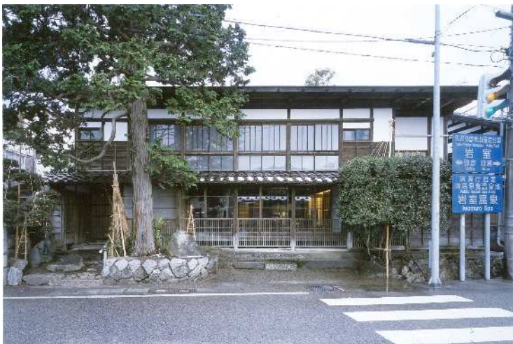
小鍛冶屋(旧高島家住宅)主屋 外観(東面) 撮影:田村収
